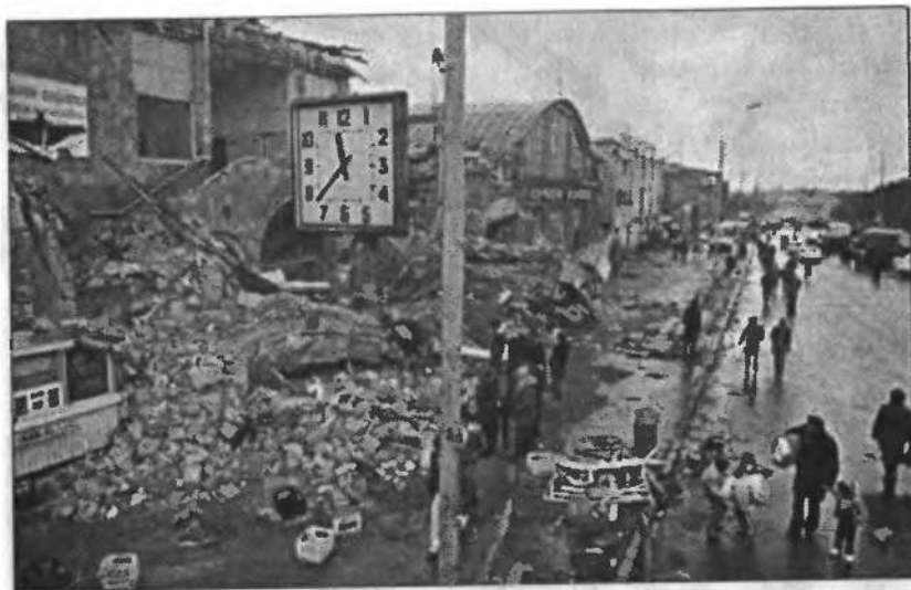
Землетрясение в Ленинкане (Армения, декабрь 1988 г.)
