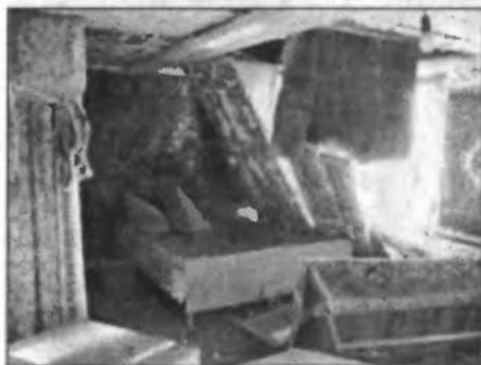
Типичные повреждения зданий в результате 7–8-балльного землетрясения
